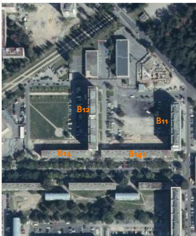
Vue sur les îlots Berthe Morisot pendant le chantier des constructions neuves chantier. Percement de la rue Degas.
