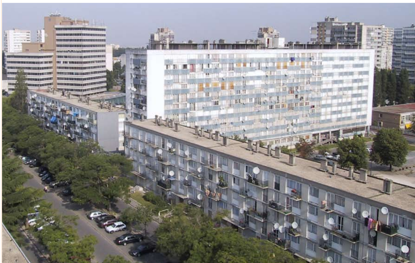
Implantation des bâtiments d'origine. La barre «B12» de 10 étages est en attente de démolition.
