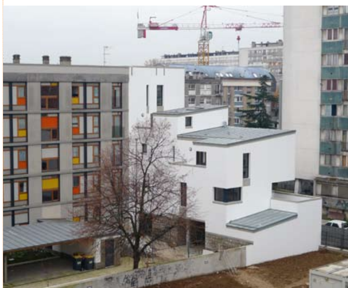
Bâtiment d'angle 1I. Accroche et retournement de la barre «B14a» réhabilitée.
