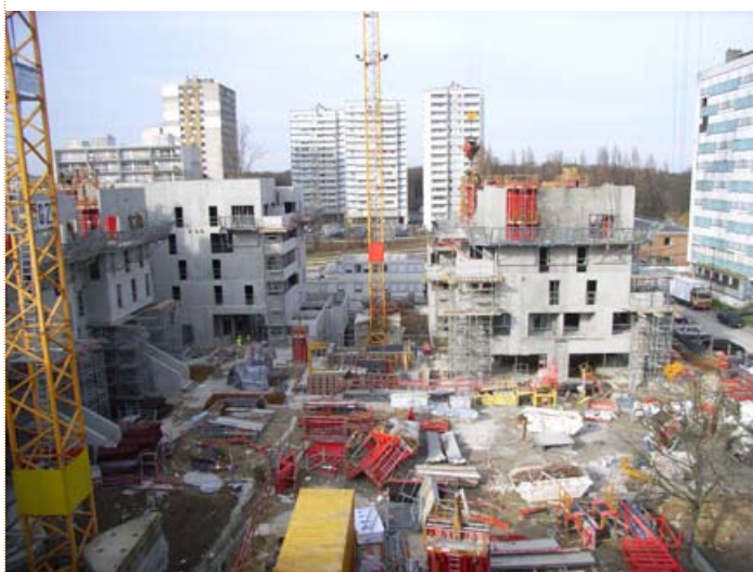
Chantier de l'îlot I. Structure en voiles béton des bâtiments neufs.
