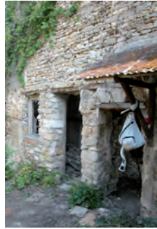
L'ACCÈS À LA GRANGE © ATELIER15
