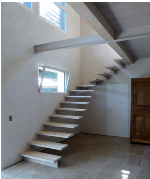
ESCALIER EN COURS DE RÉALISATION
