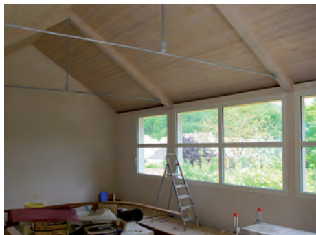
L'ÉTAGE EN COURS DE RÉALISATION
