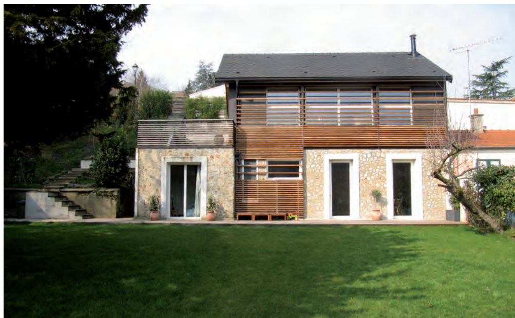
LA SURÉLEVATION APRÈS TRAVAUX
