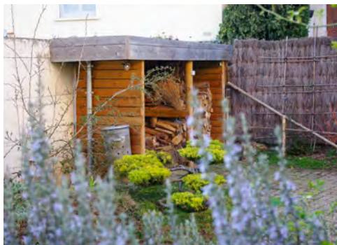
ABRI BOIS EN COHÉRENCE AVEC L'EXTENSION
