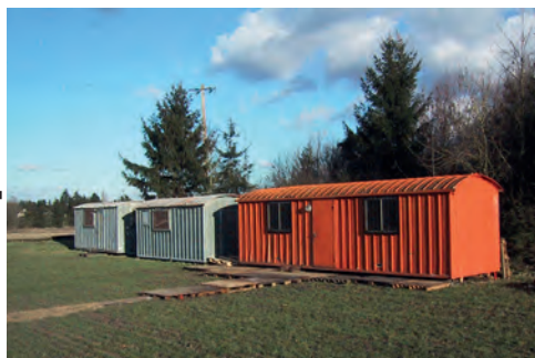
LES VESTIAIRES DE FOOTBALL EXISTANTS
