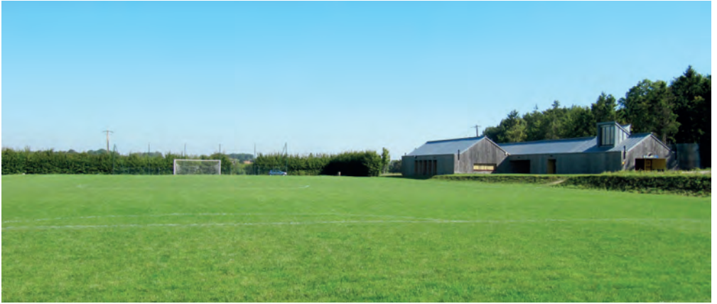
INSERTION DU BÂTIMENT DANS LE PAYSAGE, ADOSSÉ AU BOIS - VUE DEPUIS LE TERRAIN DE FOOTBALL
