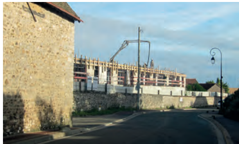
DÉBUT TRAVAUX DES LOGEMENTS OPIEVOY
