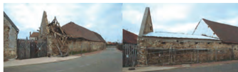
EN HAUT : PREMIÈRE RÉUNION D'ACTEURS, EN BAS : TRAVAUX DE SÉCURISATION DES TOITURES.
