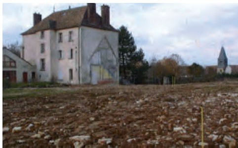
DÉMOLITION DES BÂTIMENTS DE LA FERME.
