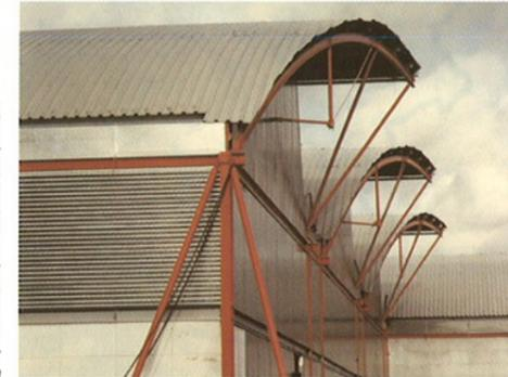
L'usine Thomson à Guyancourt a été conçue par l'architecte italien Renzo Piano, en 1989. Les structures métalliques apparentes et le bardage en acier permettent des courbes audacieuses.
