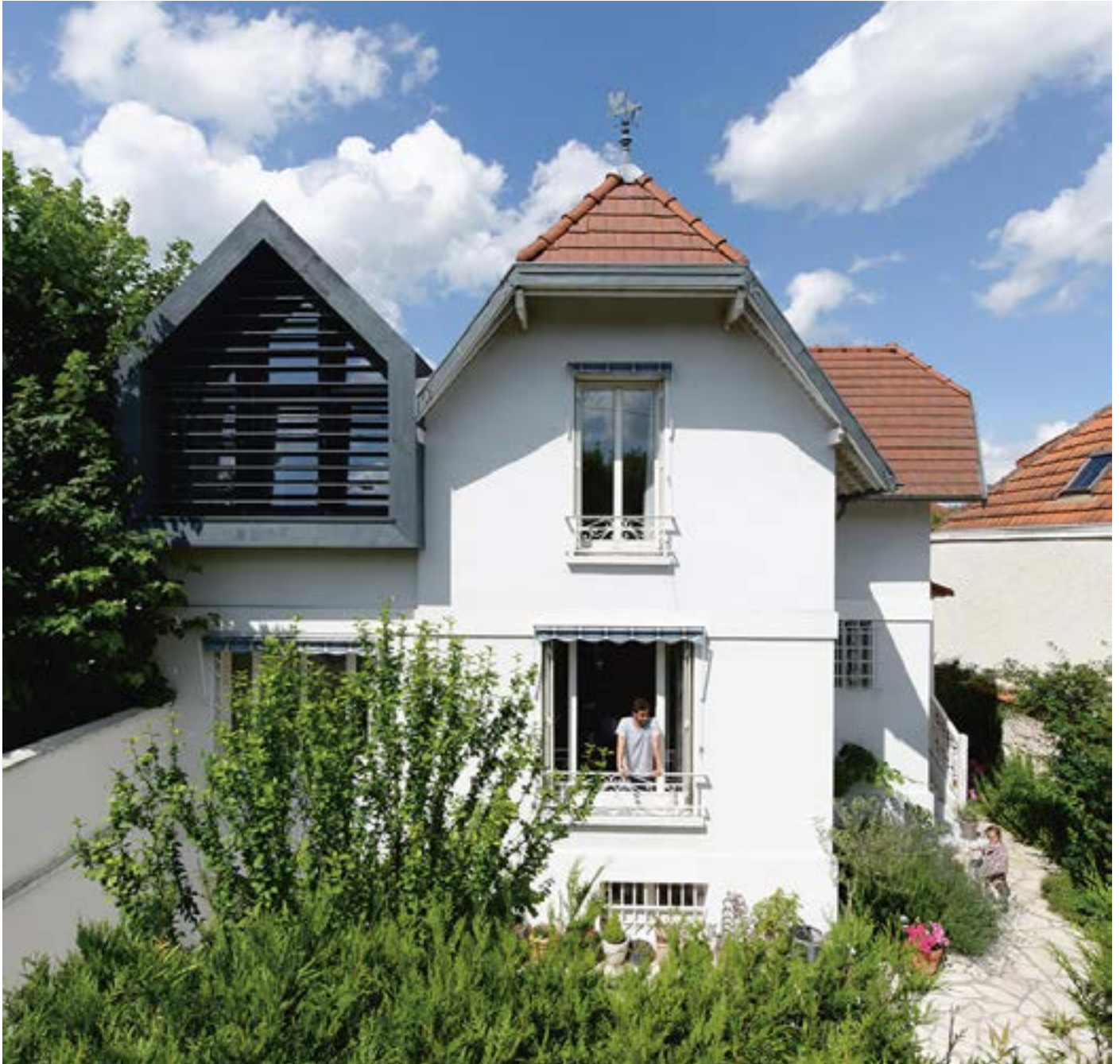
surélévation partielle - THE Architecte - Saint-Maur-des-Fossés (94) - 2012
