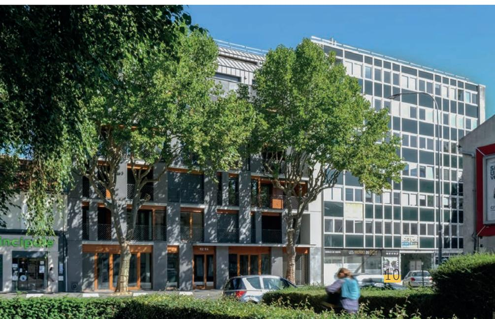
↳ La transformation de cet immeuble de bureaux avec une façade rideau de 6 étages en rétablissant l'alignement sur rue par la construction de loggias dans l'épaisseur de 3m, a permis de réaliser 27 logements en copropriété. Viroflay, JP Mallet architecte.
