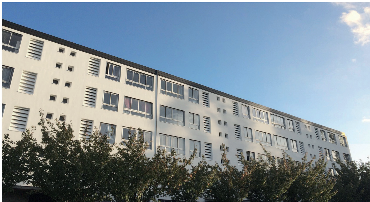
Photographie de la façade lisse après rénovation
