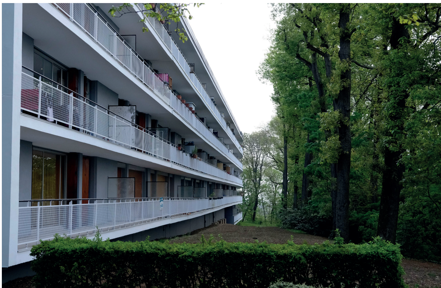
Vue sur la façade Ouest du bâtiment C
