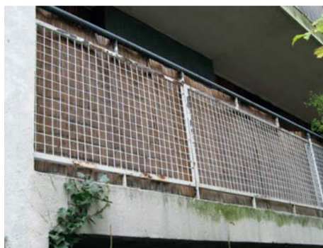
Réfection des garde-corps existants
