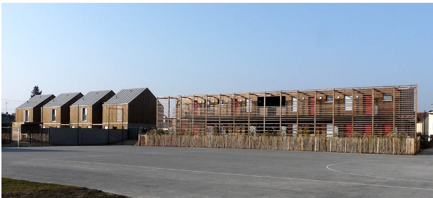
Vue générale depuis la rue des Chênes : les maisons en bande et le petit collectif © Atelier da.u, P. Arsène-Henry, P. Dandrel
