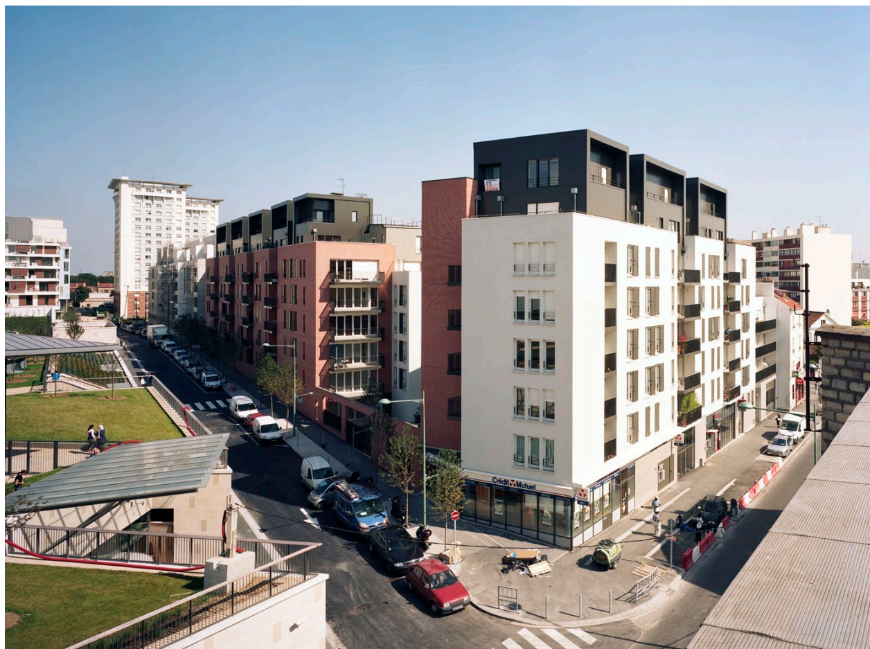
Vue extérieure sur l'ensemble de l'opération au coeur d'un secteur en reconversion © Frédéric Delangle
