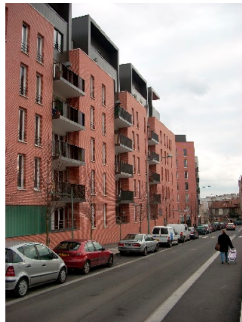
Façade sur la rue Allende. Principe du rez-de-chaussée surélevé par rapport au niveau de la rue © Frédéric Delangle
