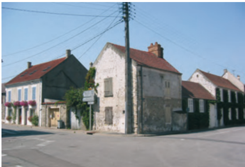
Moisson, le bâtiment avant.
