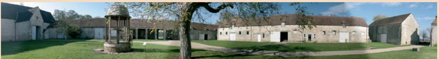
Port-Royal des Champs à Magny-les-Hameaux - Collège Saint-François d'Assise, Montigny-le-Bretonneux
