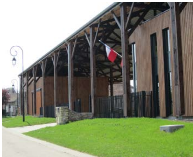
Flacourt : construction d'une mairie et de l'atelier communal sous une halle existante.
