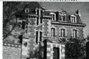
Il en est de même ici avec la pierre calcaire taillée et la brique appareillée.
