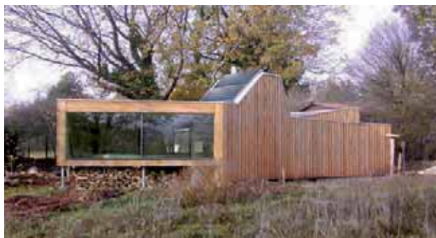
Une conception ouverte à l'énergie solaire permet des formes architecturales innovantes. Maison individuelle en Moselle © Mickaël Osswald, architecte
